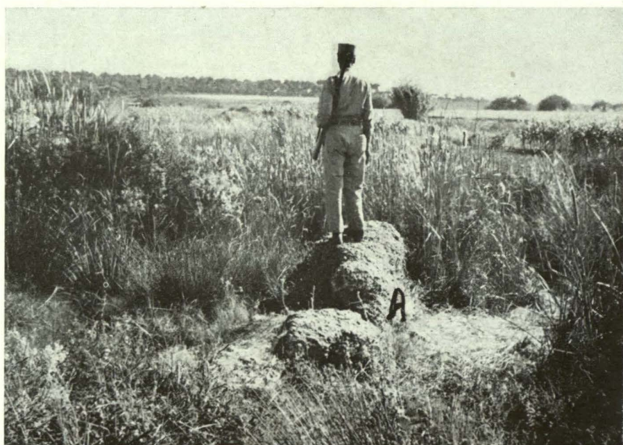
Fig. 14 — Bloco de opus signinum da Represa (B) existente no Vale Tesnado
