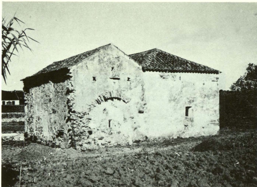
Foto 4 — A retaguarda do edifício, voltada à Serra das Pescarias, vendo-se a dentação duma muito provável abside. Percebe-se também a dentação correspondente ao prolongamento da nave lateral.
