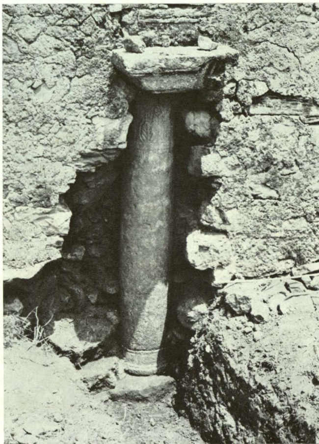
Foto 6 — Coluna monolítica com capitel visigótico insculpido. Sobre a coluna apoia-se uma imposta de mármore de recorte boleado que parece material romano de aproveitamento.
