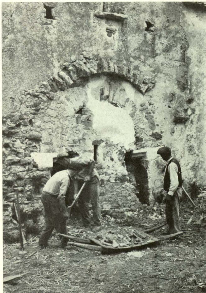
Fotos 1 e 2 — Arco que abria do cruzeiro para a abside. Vê-se nitidamente a dentação da abóbada de canhão da abside (observar na foto 13 os fundamentos da abside postos a descoberto nesta fase).
