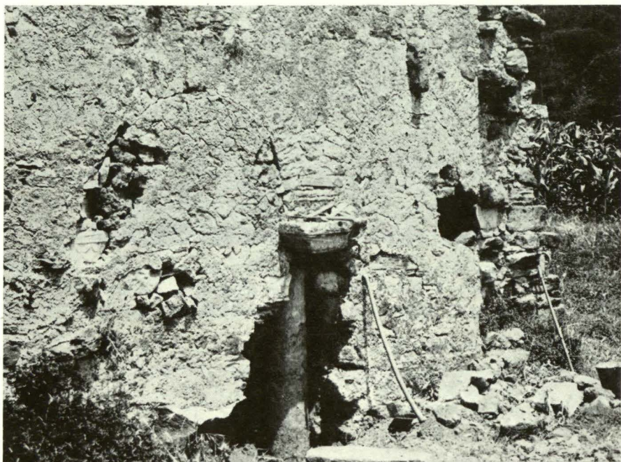
Foto 5 — Dois arcos ultrapassados fazem a comunicação entre a nave central e cada uma das naves laterais. Distinguem-se as impostas-ábaco de calcáreo donde arrancam os arcos (ver também foto 7). Ao centro a coluna monolítica (ver fotos 6, 7 e 9).
