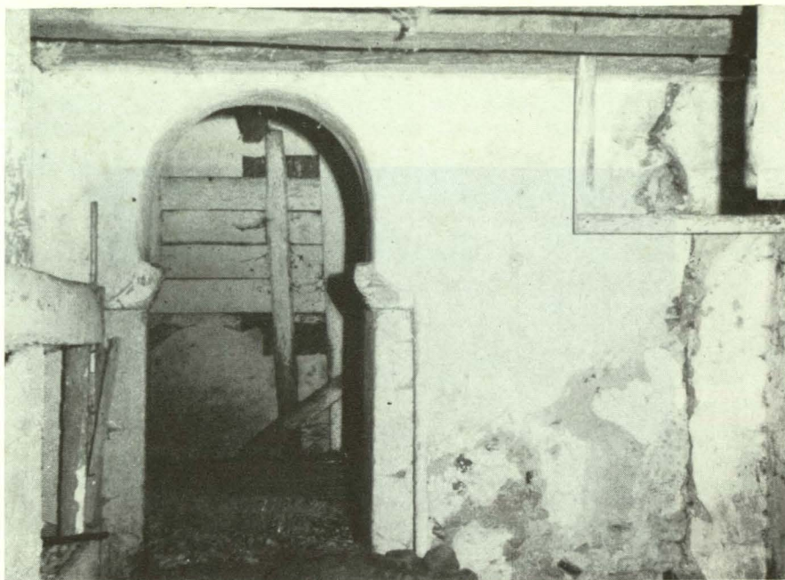
Foto 15 — Arco peraltado no interior da nave central . Repare-se no esboço dum arco semelhante, à direita. Iconostase?
