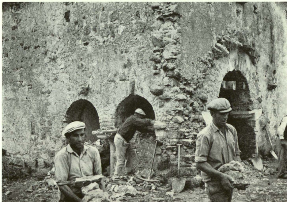
Fotos 5 e 6 — Arcos peraltados que ligariam o cruzeiro com uma das naves laterais. Os arcos são suportados no centro por uma coluna monolítica tipicamente visigótica. Os arranques laterais são impostas-ábaco com quadrifólios e SS. Duas fases da desobstrução.
