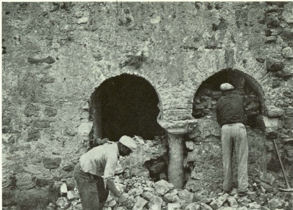
Fotos 5 e 6 — Arcos peraltados que ligariam o cruzeiro com uma das naves laterais. Os arcos são suportados no centro por uma coluna monolítica tipicamente visigótica. Os arranques laterais são impostas-ábaco com quadrifólios e SS. Duas fases da desobstrução.
