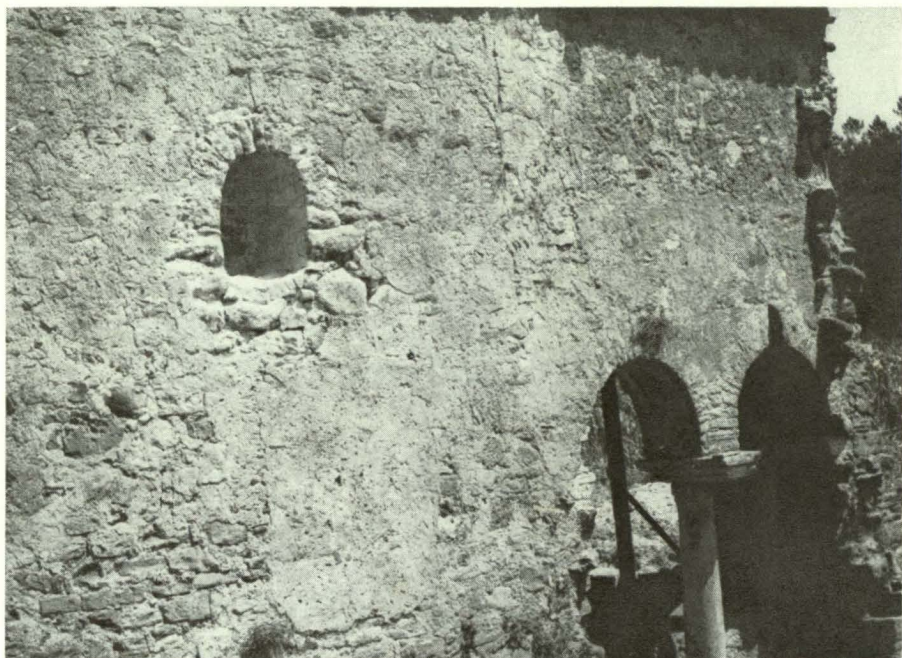
Foto 12 — Na parede voltada para uma das naves laterais surgiu um nicho de tipo côncavo.
